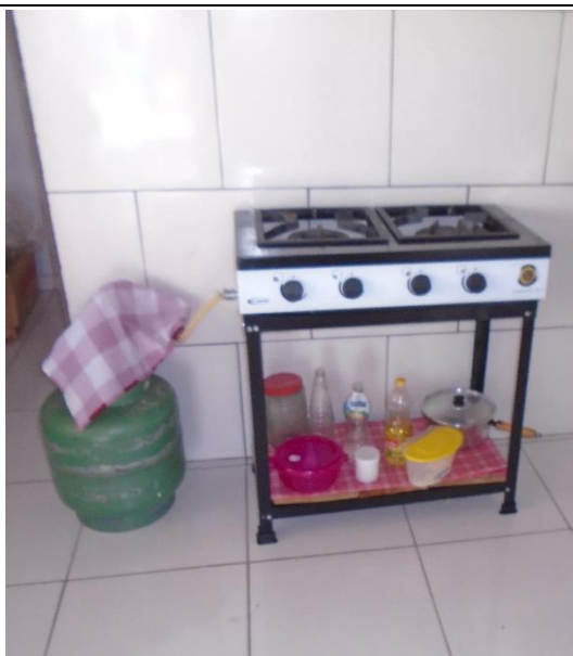
Foto 01 - Botijão de gás dentro da cozinha (sem abrigo na parte exterior da edificação NBR 13.523) – Escola Ver. Joaquim Liberato
