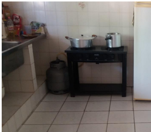
Foto 03 - Botijão de gás dentro da cozinha (sem abrigo na parte exterior da edificação NBR 13.523) – Escola Maria auxiliadora B. F. da cunha.
