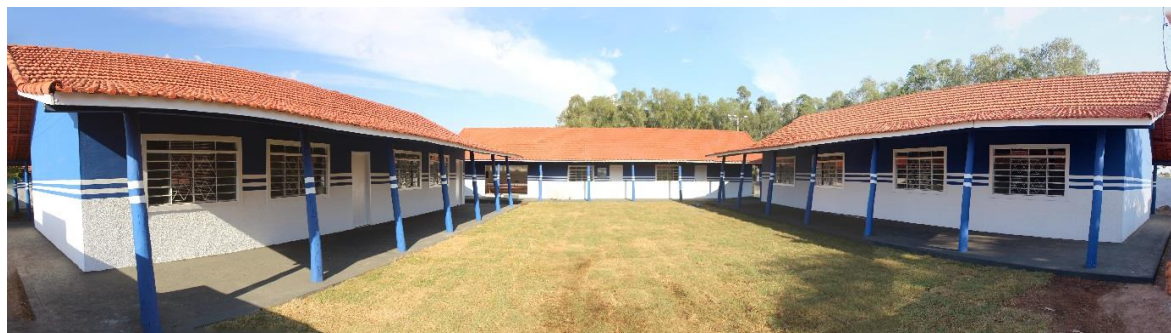
Foto 03 e 04 – Escola Municipal Vereador Joaquim Liberato, após reforma em sua estrutura, incluindo cozinha e depósito de alimentos.
