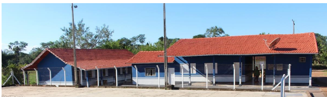
Foto 01 e 02 – Escola Municipal Alzira Correia dos Santos, após reforma em sua estrutura, incluindo cozinha e depósito de alimentos.
