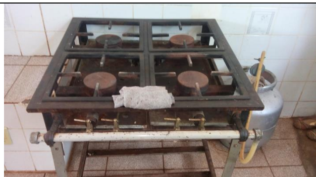
Foto 10 – fogão velho, enferrujado e Botijão de gás na cozinha (sem abrigo na parte exterior da edificação – NBR/ABNT 13523), Figueirópolis D'Oeste - MT, 25/10/2016.
