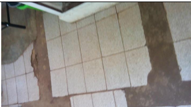
Foto 09 – piso da cozinha escolar inadequado (item 4.1.3 da Resolução-RDC Anvisa 216/2004), Figueirópolis D'Oeste - MT, 25/10/2016.
