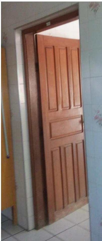
Foto 01 – Porta que dá acesso a cozinha sem proteção nas aberturas inferiores para impedir a entrada de insetos e roedores e sem fechamento automático, com livre acesso aos funcionários da escola, (item 4.1.4 da Resolução-RDC Anvisa 216/2004). Escola Maria Auxiliadora (creche), Figueirópolis D'Oeste - MT (MT), 21/10/2016.
