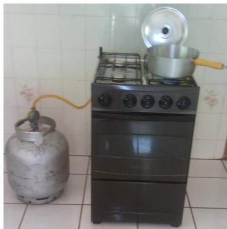
Foto 08 - Botijão de gás na cozinha (sem abrigo na parte exterior da edificação – NBR/ABNT 13523), Escola Maria Auxiliadora (creche), Figueiropolis D'Oeste - MT (MT), 21/10/2016.
