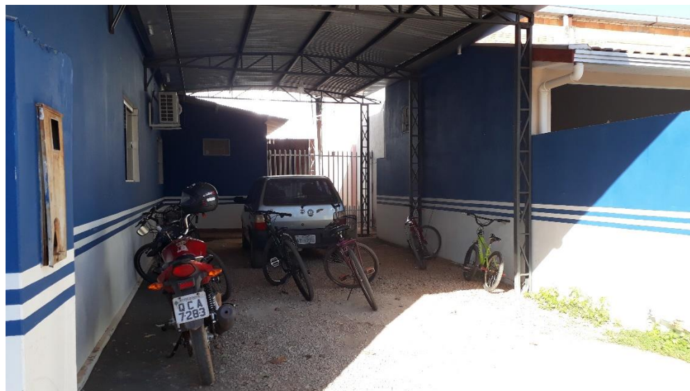
Local onde os veículos da Secretaria de Assistência social serão guardados, faltando apenas a instalação de um Portão
