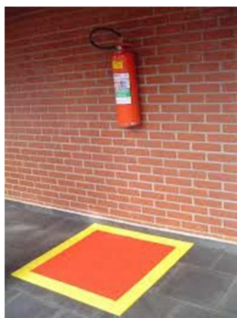
Figura 2 - Sinalização no Piso - Demarcação do Extintor
