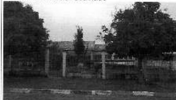
Foto: meio fio não rebaixado
