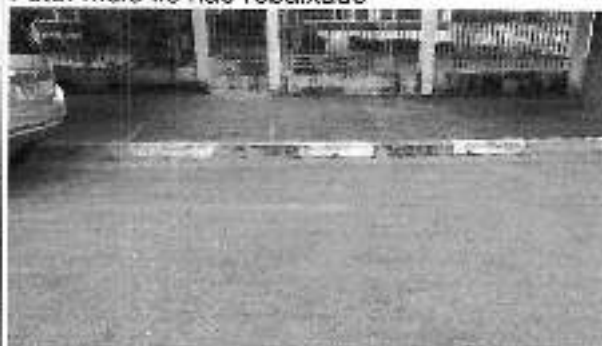
Foto: meio fio não rebaixado
