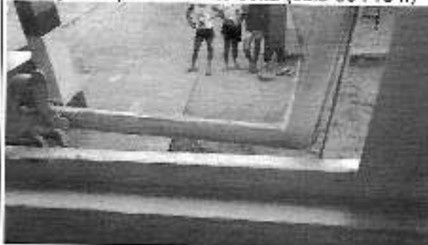
Foto: janela parcialmente solta (sala do Pré II)
