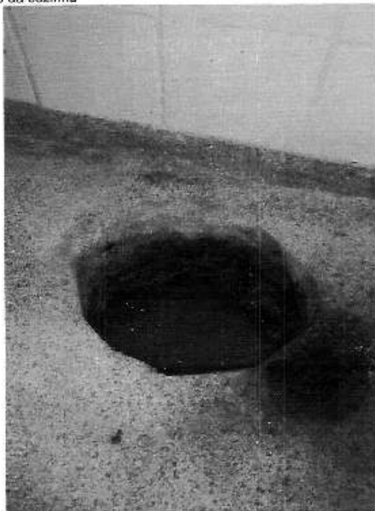
Foto: esgoto dentro da cozinha
