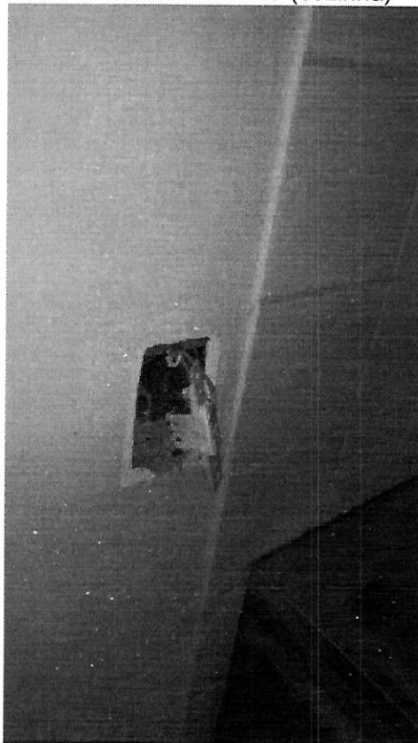
Foto: Tomada elétrica (cozinha)
