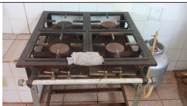
Foto 10 – fogão velho, enferrujado e Botijão de gás na cozinha (sem abrigo na parte exterior da edificação – NBR/ABNT 13523), Figueirópolis D'Oeste - MT, 25/10/2016.
