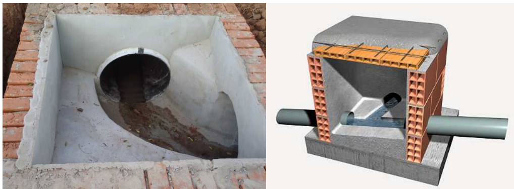
Figura 2 e 3 – Fundo das caixas de inspeção
