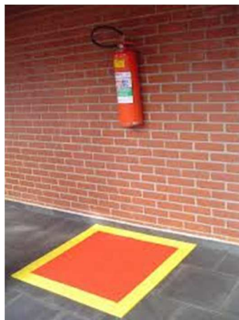
Figura 2 - Sinalização no Piso - Demarcação do Extintor
