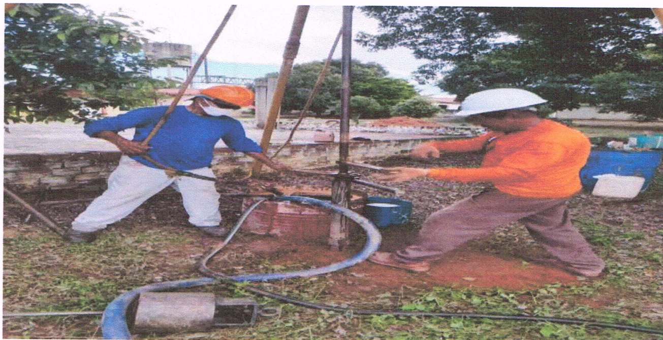
Figura 2: sondagem a percussão spt, aumentando haste.
