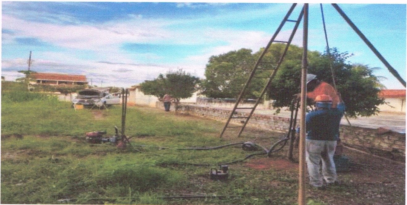
Figura 4: sondagem a percussão spt, lavagem do furo.
