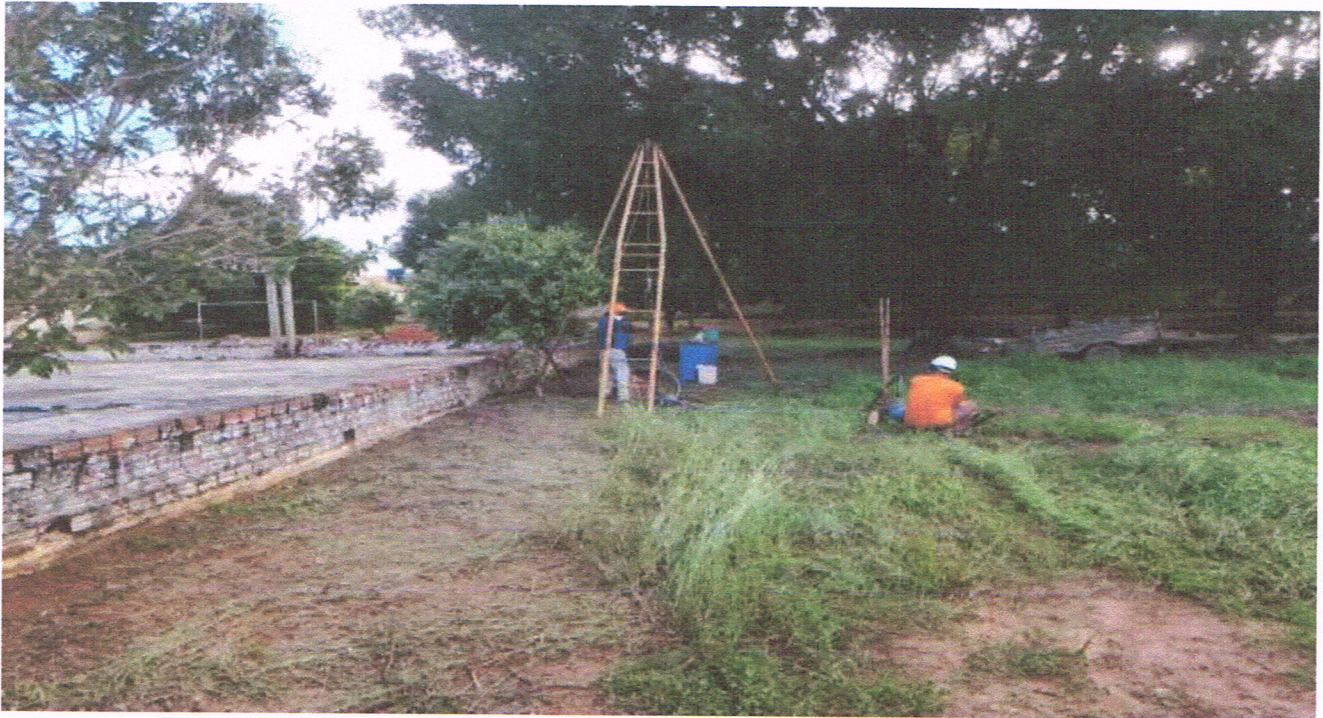
Figura 3: execução de lavagem do furo.
